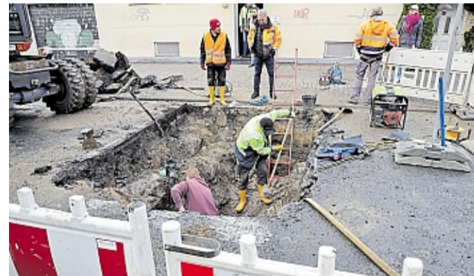
Der Schaden war gestern zur Mittagszeit bereits behoben, die folgenden Bauarbeiten werden aber noch andauern.
